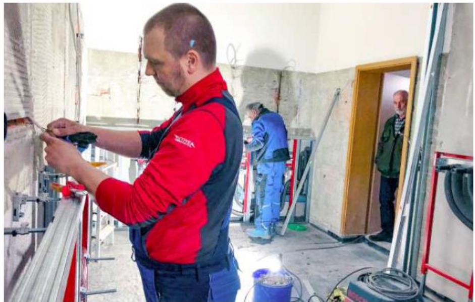
Ronny Wagner (vorn) und Klaus-Dieter Fischbach, Mitarbeiter der Firma Elektro-Wagner Bad Suderode, bei Elektroarbeiten im Duschaum des Feuerwehrgerätehauses Gernrode. FOTOS (2): KORN
