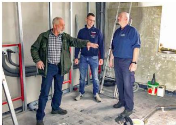
Dieter Mahlow, Mitarbeiter Bauverwaltung, Ortswehrleiter Florian Gesche und Gruppenführer Peter Winter (v. l.) im Gespräch zu den laufenden Arbeiten.
